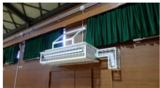
(写真2) 壁取り付け型室内機
