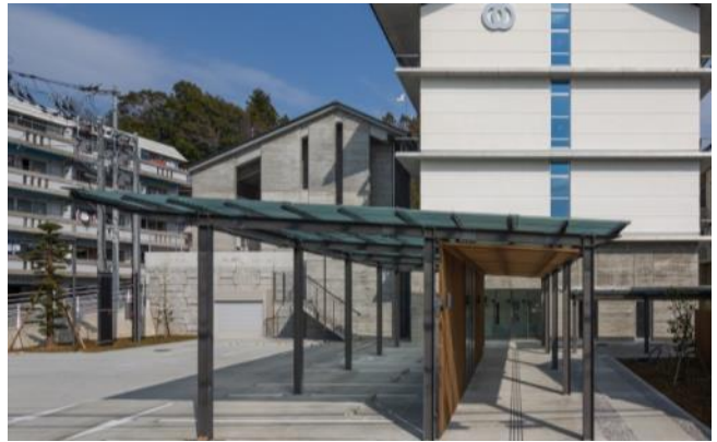
図 3-20 障害者等用駐車場からのアクセスの事例（いの町）
