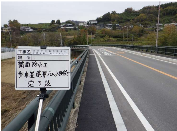
橋面防水(歩道部)施工後
