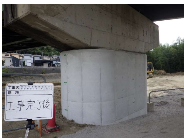
P4橋脚施工後
