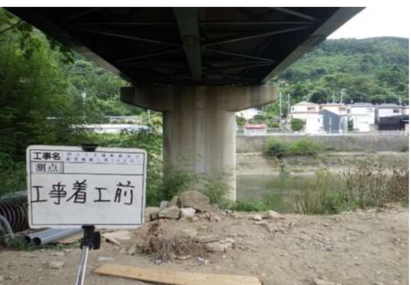
P3橋脚施工前
