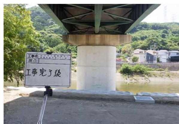
P3橋脚施工後
