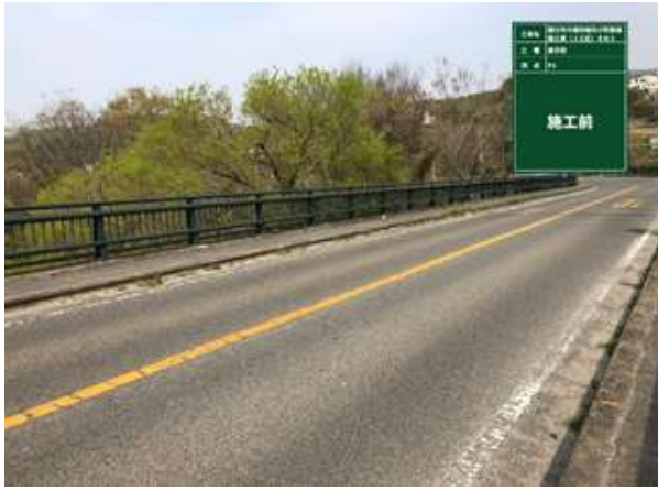
橋面防水(車道部)施工前
