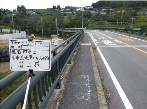
橋面防水(歩道部)施工前
