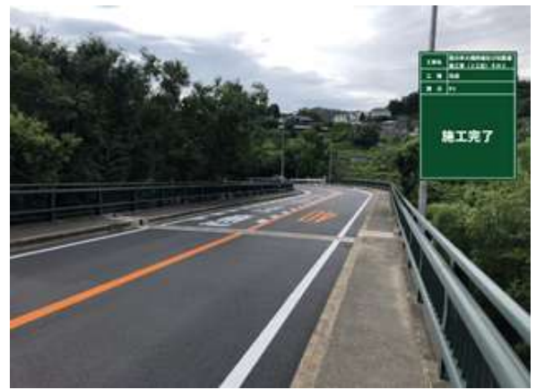
橋面防水(車道部)施工後
