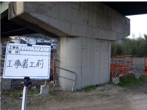
P4橋脚施工前
