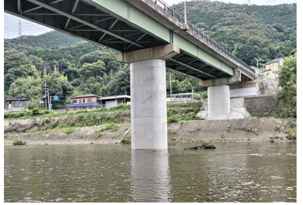
P2橋脚施工後
