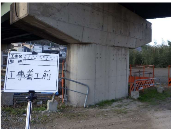
P4橋脚施工前
