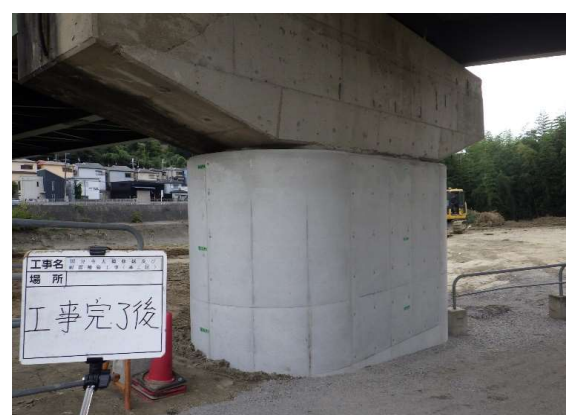
P4橋脚施工後
