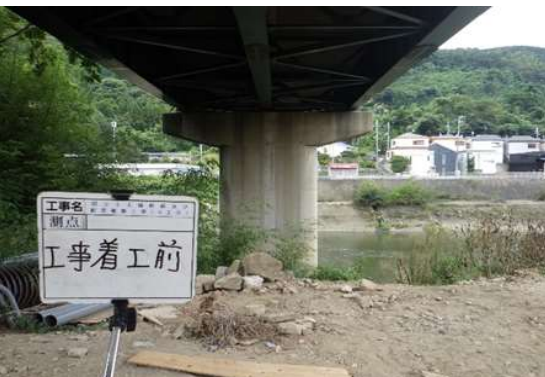
P3橋脚施工前
