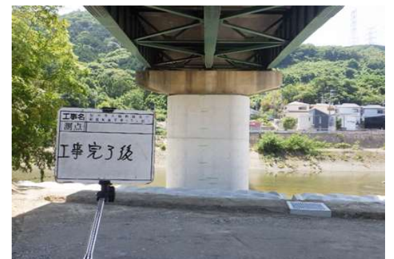
P3橋脚施工後
