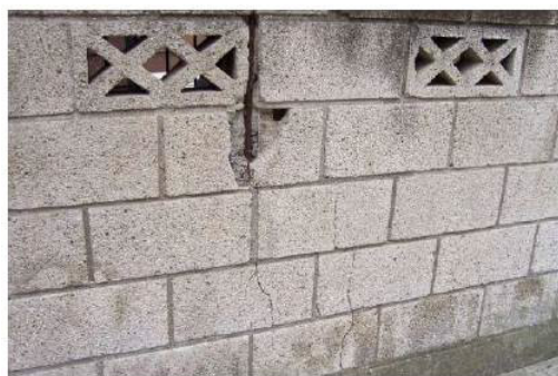
塀に大きなひび割れが生じている
