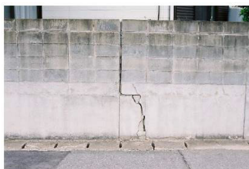
塀に大きなひび割れが生じている
