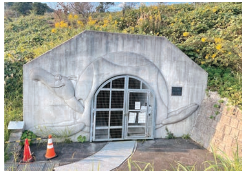
排水トンネル（亀の瀬）
