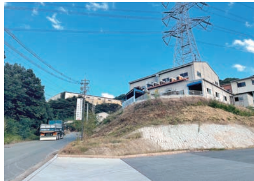
柏原鉄工金属団地
