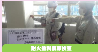
耐火塗料膜厚検査
