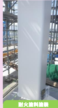
耐火塗料塗装
