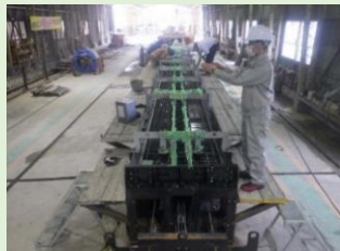
■プレキャスト床版の配筋と型枠の検査
