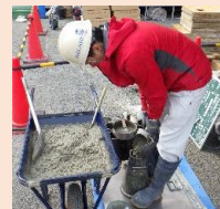
■ 生コンをスランプコーンに詰める様子
