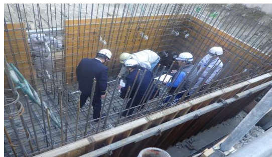
④オイルタンク消防検査状況
