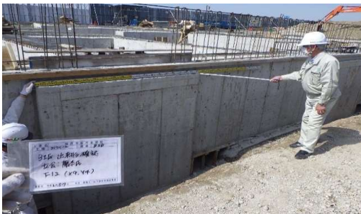
①基礎寸法確認
