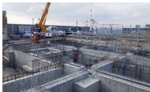
④基礎型枠脱型状況
