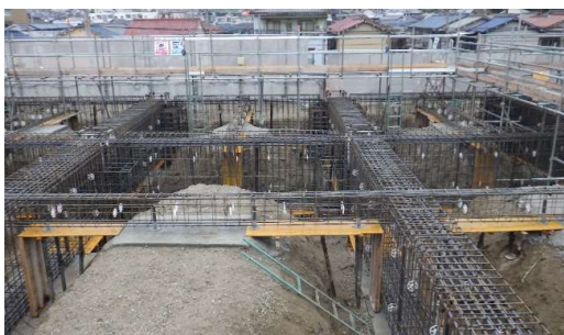
①鉄筋工事状況
