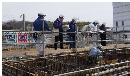
②型枠・鉄筋組み立て検査状況
