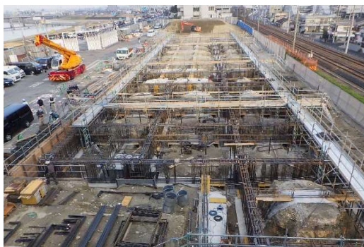
コンクリート打設前
