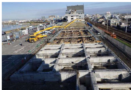
コンクリート打設後
