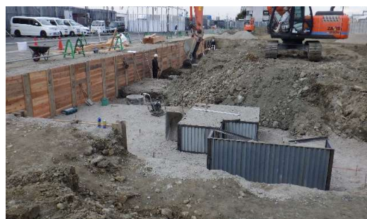
②掘削工事状況
