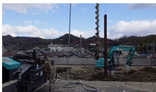
①土留状況
