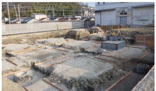
③床付け、砂利敷き状況
