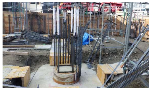
④杭頭補強筋・アンカーボルト据え付け工事状況
