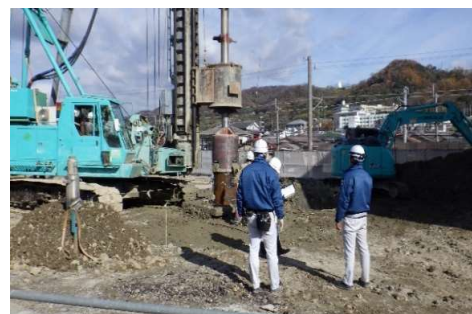
④杭建て込み
