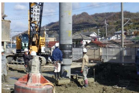
③杭接続部確認
