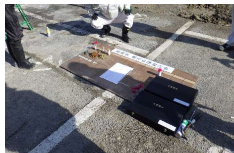
②支持層の確認状況
