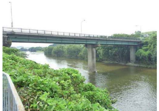
地域交通網の一翼を担う橋(例:国分寺大橋)
